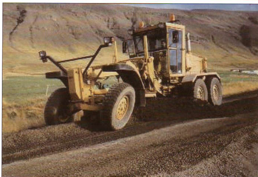
Godt arbeid med høvelen slo positivt ut på østre del av Svinadalsvegur
