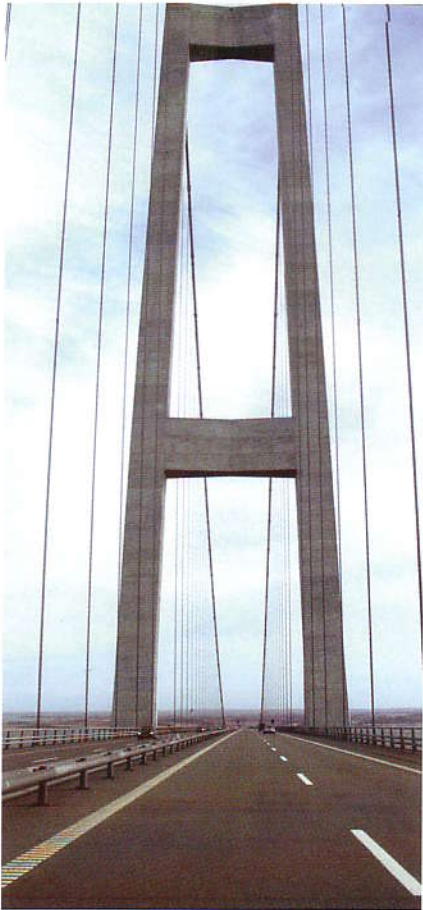
Bildet: Storebæltbroen sikres mot snø og is ved hjelp av Ice Away
